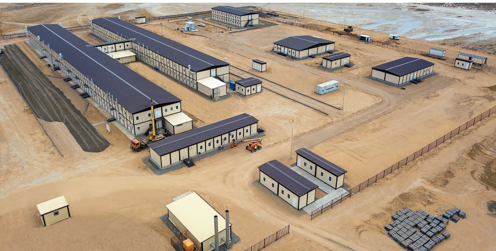
Казахстан, Атырауская обл. Строительство госпиталя
