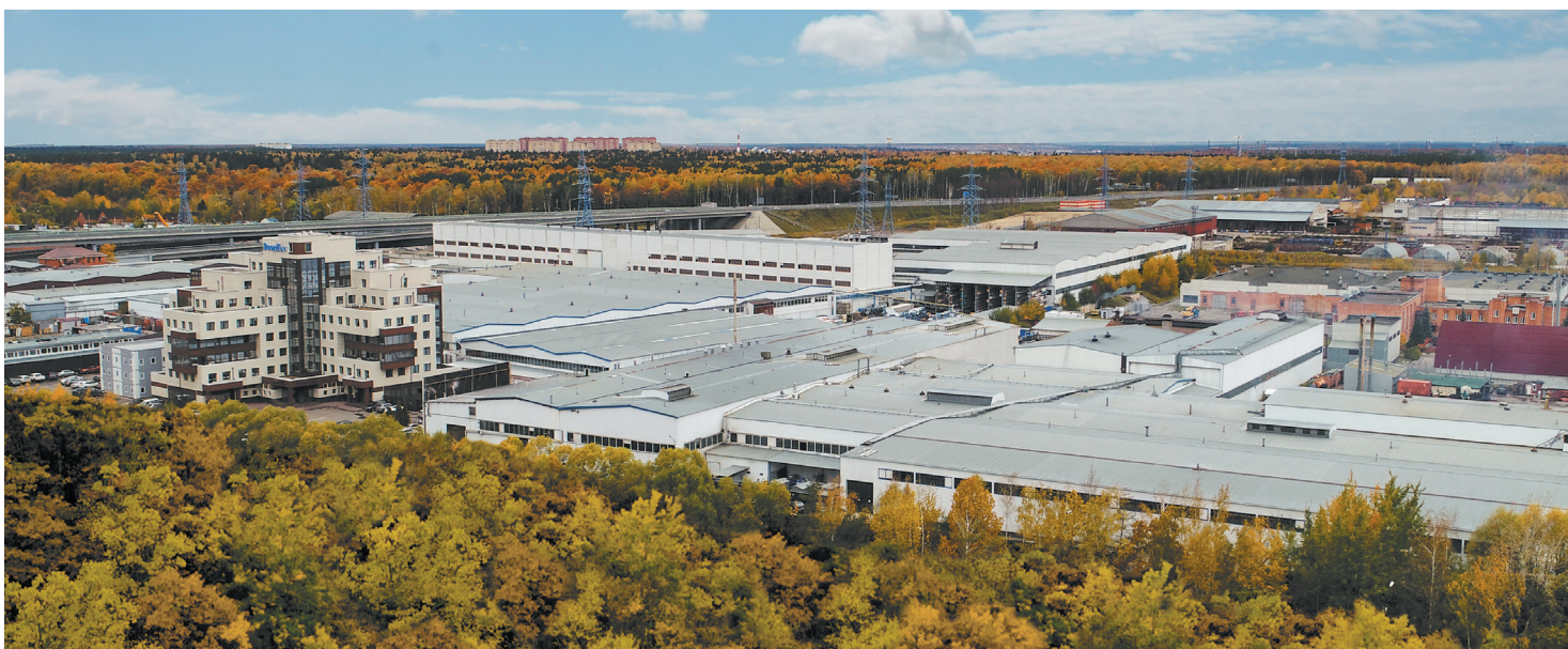
РОССИЯ, МОСКОВСКАЯ ОБЛАСТЬ. Главный производственный и распределительный центр концерна DoorHan
