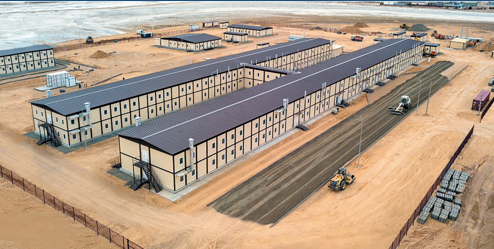
Казахстан, Атырауская обл. Строительство госпиталя
