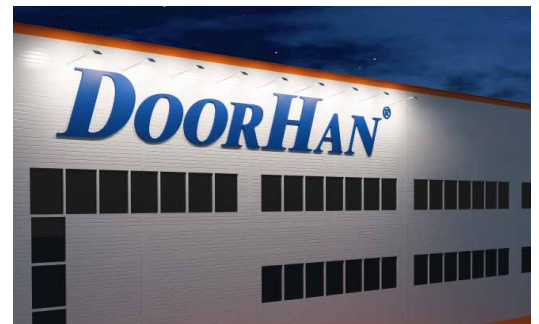
Фасад. Вид ночью
